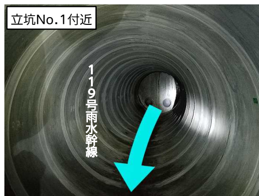
推進管設置完了状況(内部)
