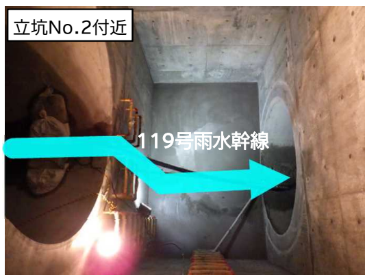
特殊人孔築造完了状況(内部)
