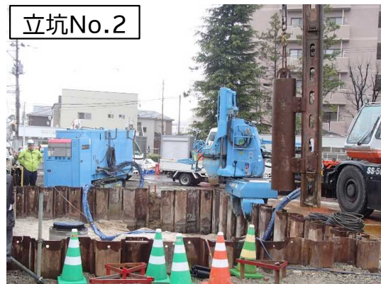
仮設土留(鋼矢板)撤去状況
