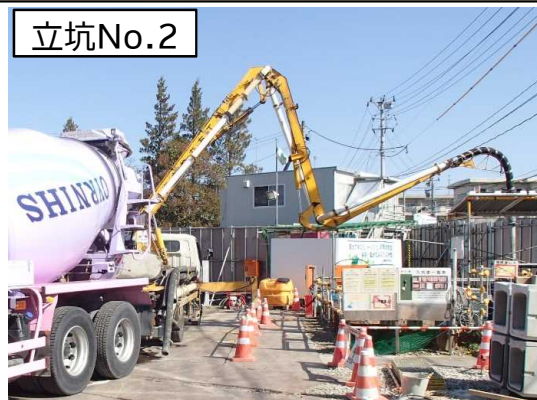
特殊人孔築造(コンクリートポンプ車投入打設)状況
