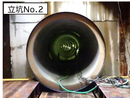
推進工法(L1-M管布設)完了状況
