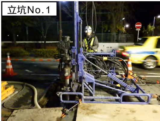
地盤改良(薬液注入)状況
