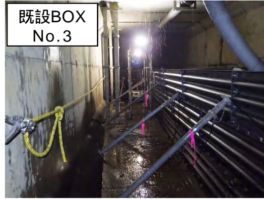
既設BOX補強支保工及び仮締切排水状況
