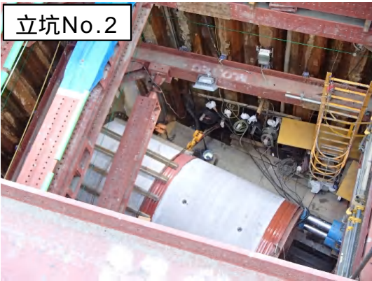
推進工法(ヒューム管布設)状況
