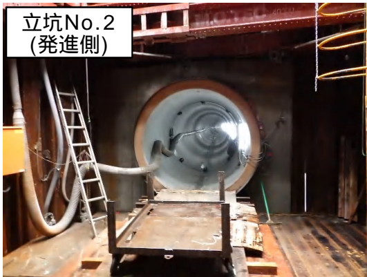
推進工法(U-M管布設完了)状況
