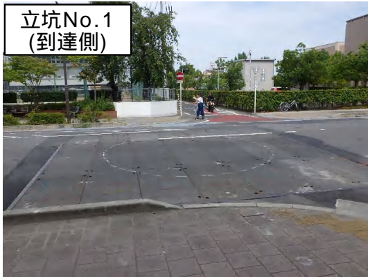
覆工板設置(ライナープレート設置箇所)状況
