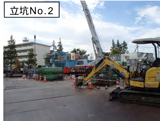
推進設備(泥水式)撤去状況
