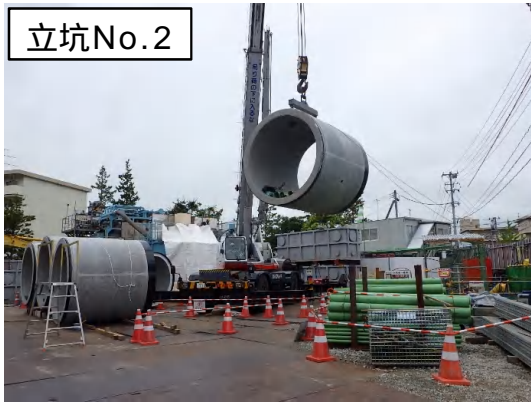
推進工法(U-M管布設)状況
