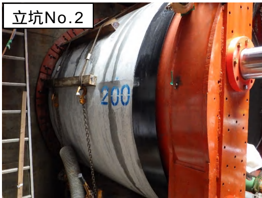
推進工法(U-M管布設)状況
