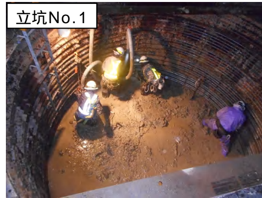
掘削(ライナープレート設置)状況
