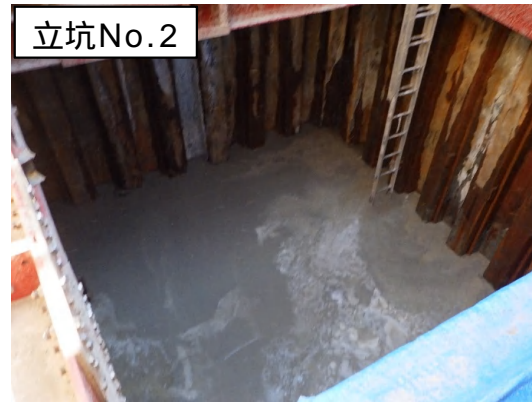
均しコンクリート打設完了状況
