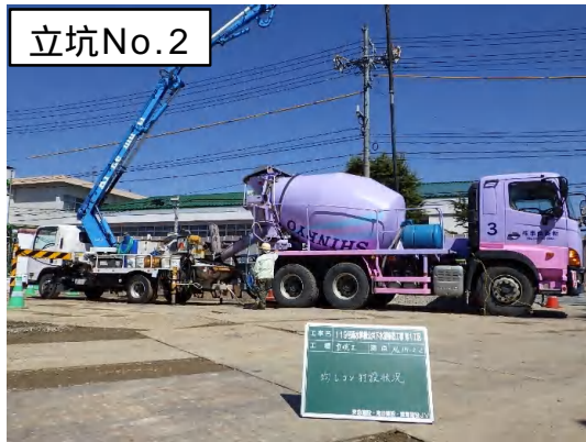
コンクリートポンプ車打設状況
