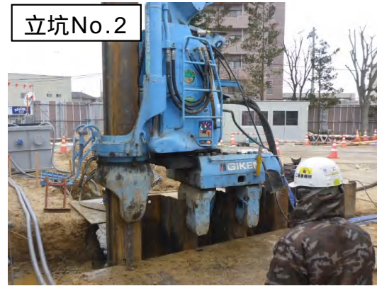
仮設土留(鋼矢板設置)状況
