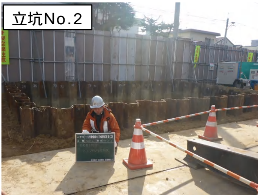
仮設土留(鋼矢板設置完了)状況
