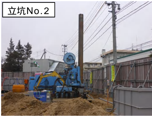
仮設土留(鋼矢板設置)状況
