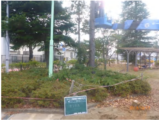
支障物撤去(樹木伐採)状況
