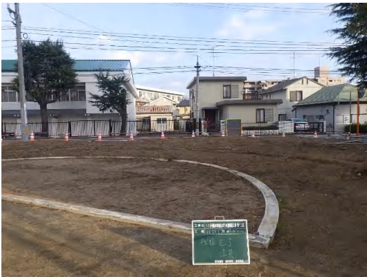
支障物撤去完了状況
