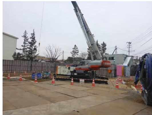
敷鉄板及び仮囲い設置状況
