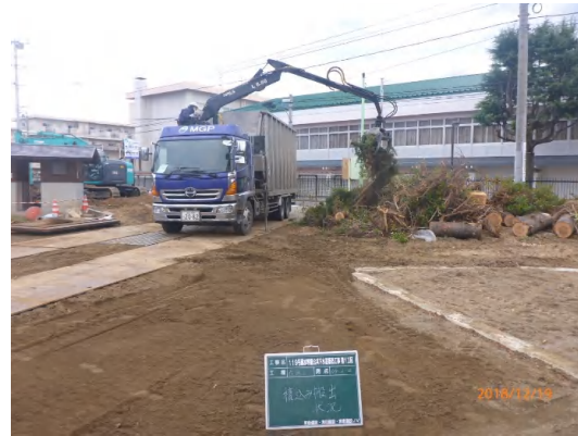
支障物撤去(積込・運搬)状況
