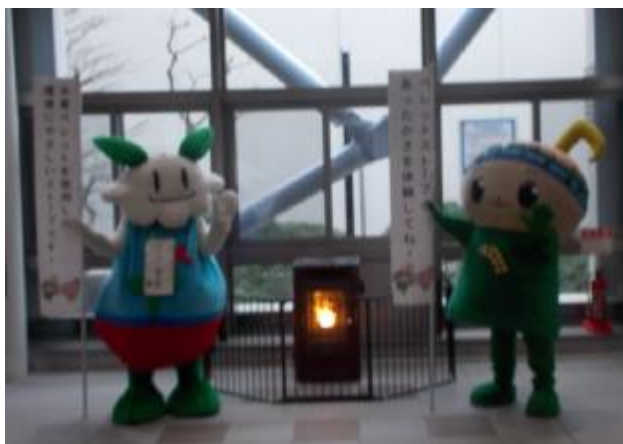
市役所本庁舎1階に設置されたペレットストーブ
