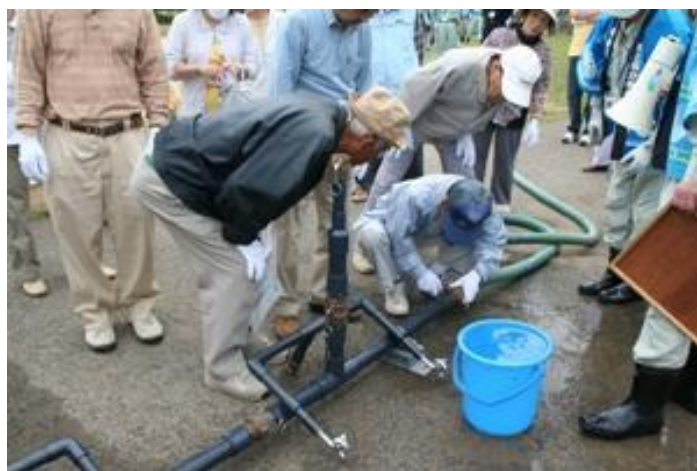
「知って安心、耐震性貯水槽」(耐震性貯水槽操作訓練)の様子
