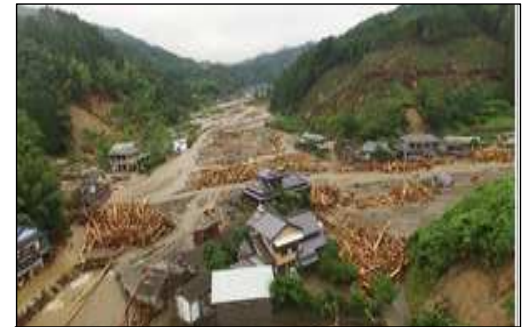
赤谷川が氾濫し流木と土砂に埋もれた (九州北部豪雨)
