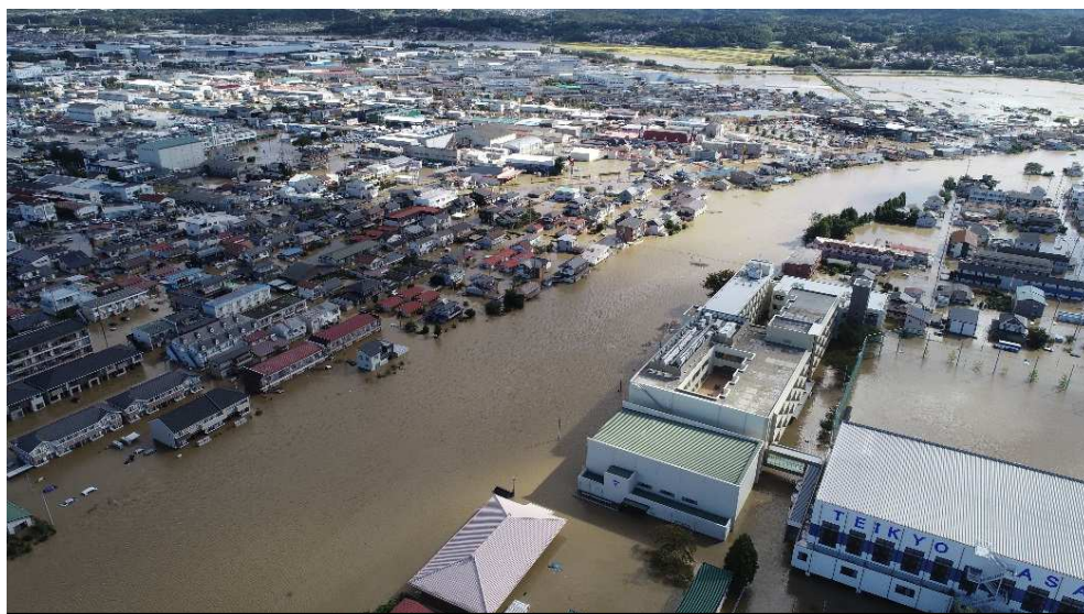
安積町日出山(阿武隈川)付近
