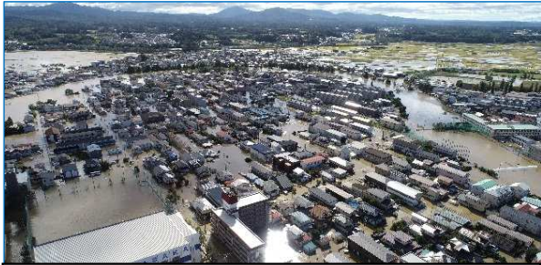
水没した住宅街（安積町日出山付近）
