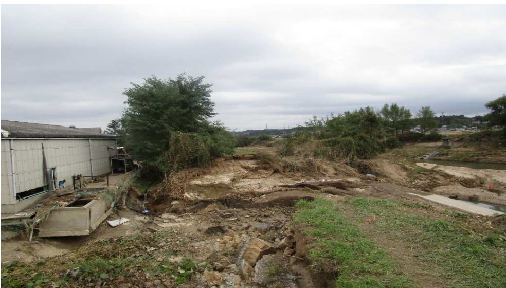
中央工業団地（谷田川の堤防決壊）付近
