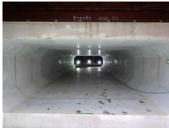
ボックスカルバート布設完了
