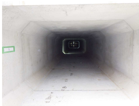
ボックスカルバート布設完了
