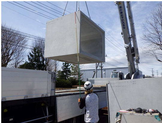
ボックスカルバート搬入状況
