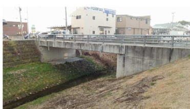
▲簡易予防保全橋梁 ・静橋（橋長 14.2m、幅員 6.0m）
