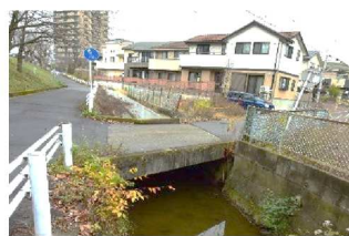
▲事後保全型橋梁 ・酒蓋橋（橋長 3.8m、幅員 3.8m）
