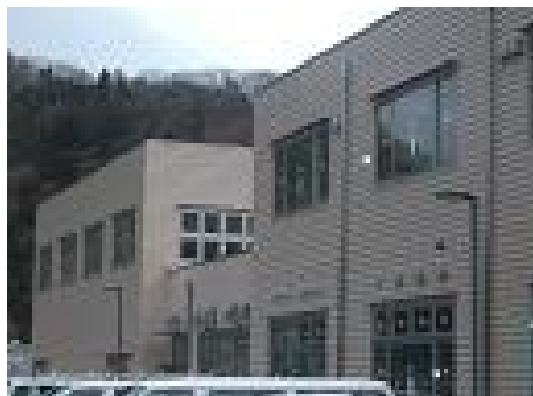
建設中の「ほっとあたま」
