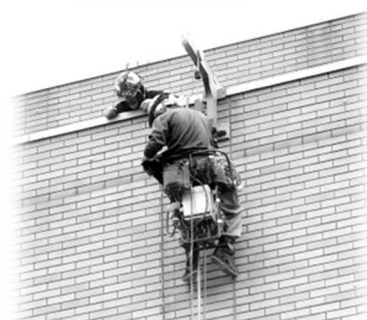
外壁調査の様子
