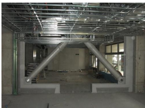
鉄骨ブレース補強の様子
