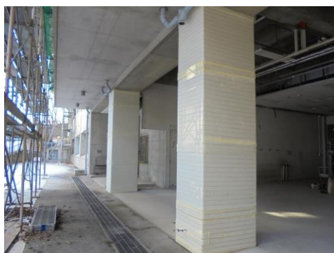
柱ポリエステルシート巻き補強の様子
