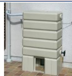
雨水貯留タンク
