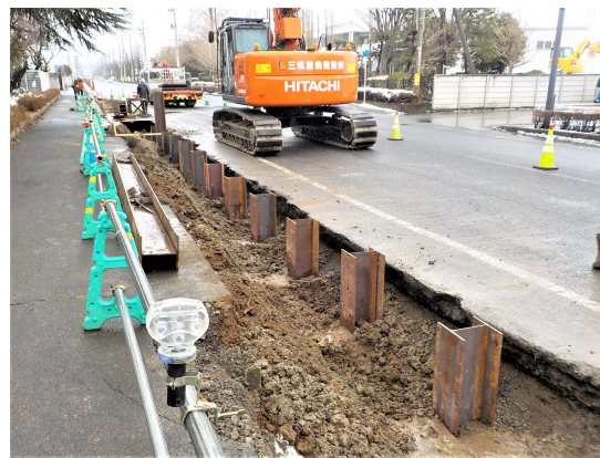
親杭（H鋼）設置状況
