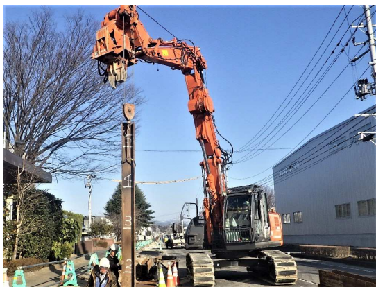
親杭（H鋼）設置状況
