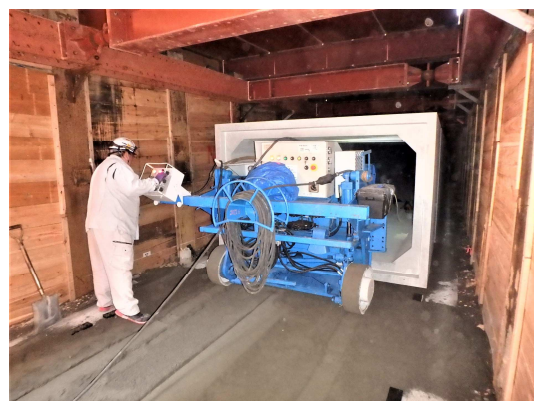
ボックスカルバート布設状況
