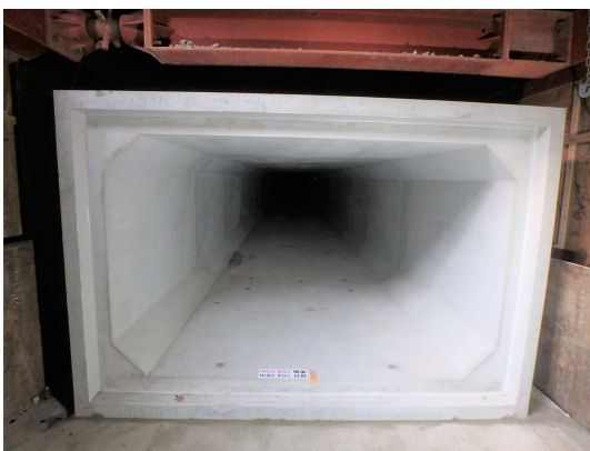
ボックスカルバート布設完了
