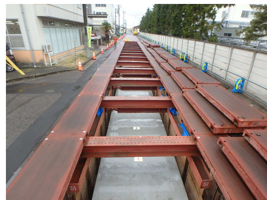
ボックスカルバート布設完了
