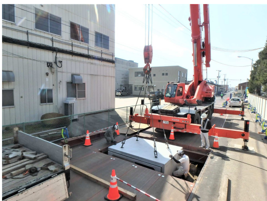
ボックスカルバート布設状況
