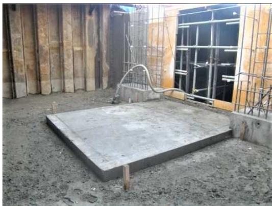
ホックスカルバート基礎コンクリート打設完了
