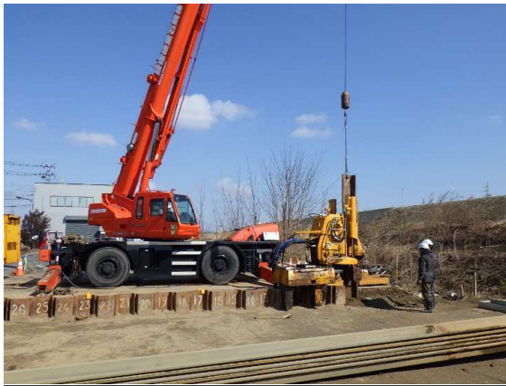
鋼矢板引抜き状況
