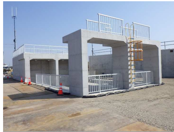
ポンプ施設部埋戻し完了
