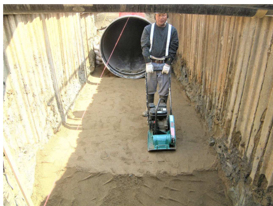
基礎砂転圧状況
