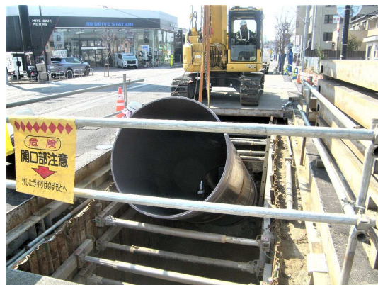
新設管布設状況
