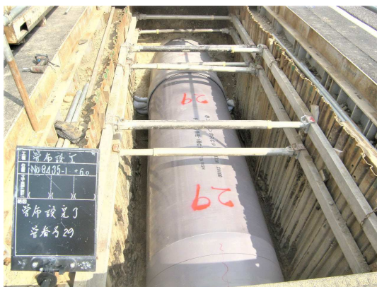
新設管布設完了
