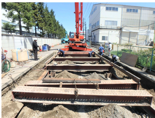
覆工板撤去状況
