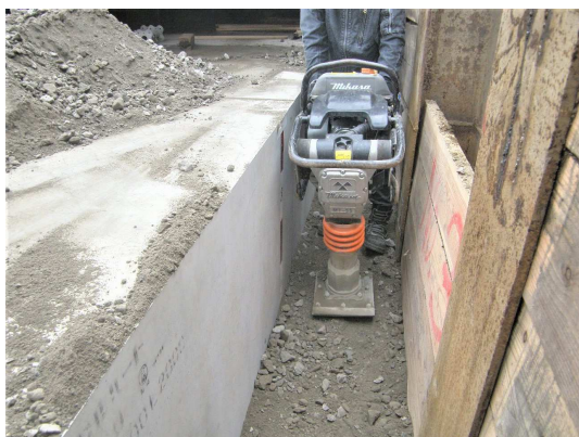
ボックスカルバート埋戻し転圧状況
