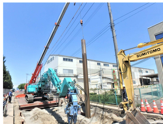
親杭引抜き状況
