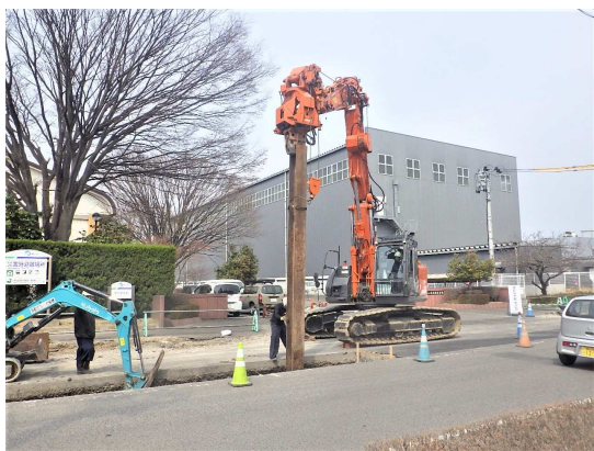
親杭（H鋼）設置状況
