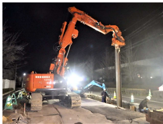
親杭（H鋼）設置状況
