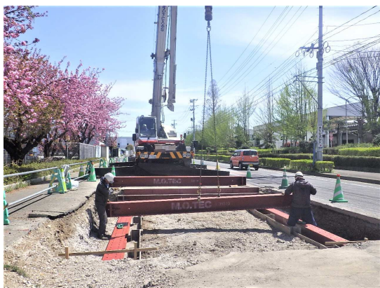
覆工板設置状況
