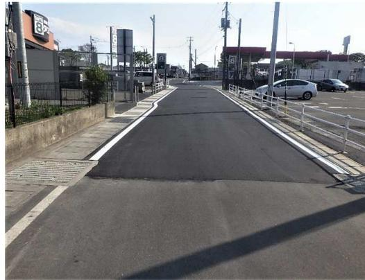
側溝再設置及び舗装仮復旧完了
