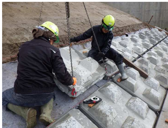
築堤部連節ブロック設置状況
