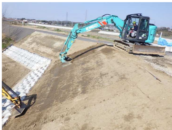
築堤盛土施工状況
