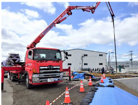
電気設備等基礎コンクリート打設状況
