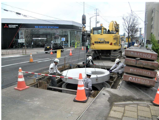
組立人孔設置状況
