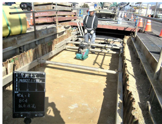
埋戻し転圧状況
