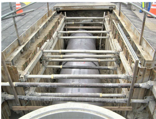
新設管布設完了
