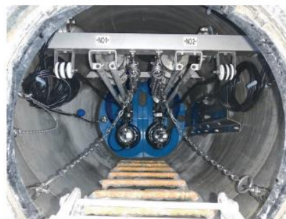
マンホール内部
