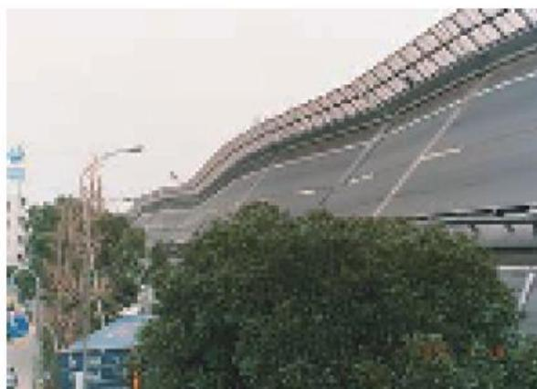
▲阪神高速道路の高架橋の倒壊 (写真提供：神戸市)
