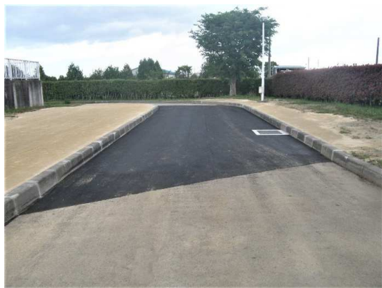
舗装仮復旧完了
