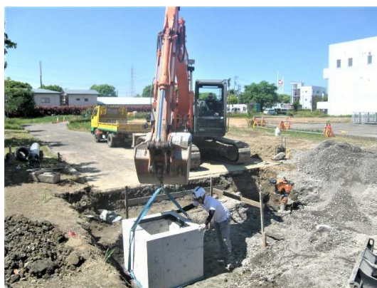
新設集水桝設置状況
