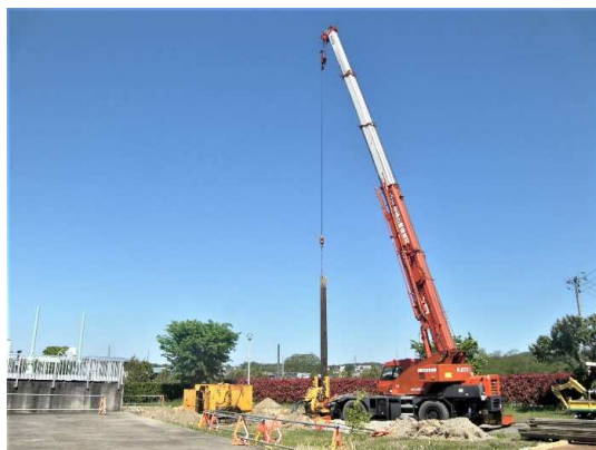
鋼矢板引抜き状況
