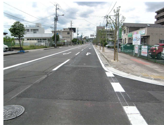
区画線復旧完了
