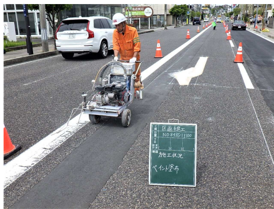
区画線復旧状況
