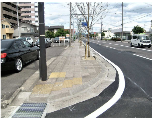
歩道部平板ブロック再設置完了
