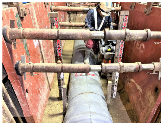
埋戻し転圧状況
