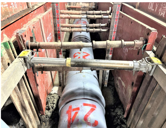
新設管布設完了
