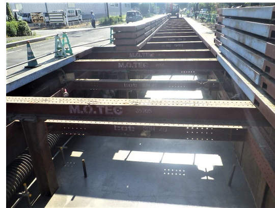
基礎コンクリート打設完了
