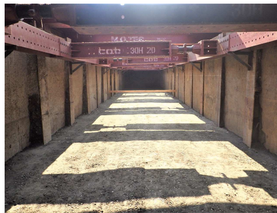
基礎碎石完了
