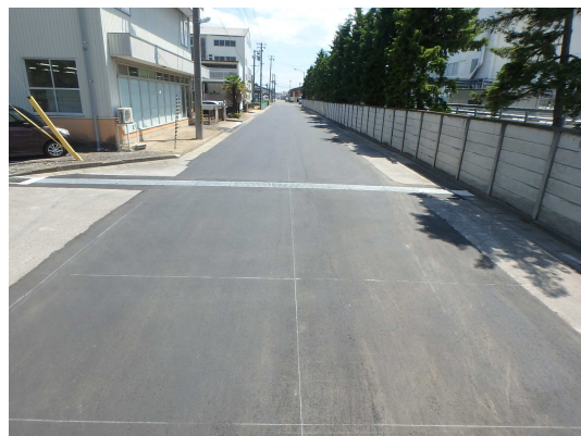
舗装仮復旧完了(北から南を望む)
