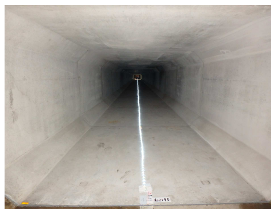
ボックスカルバート布設完了
