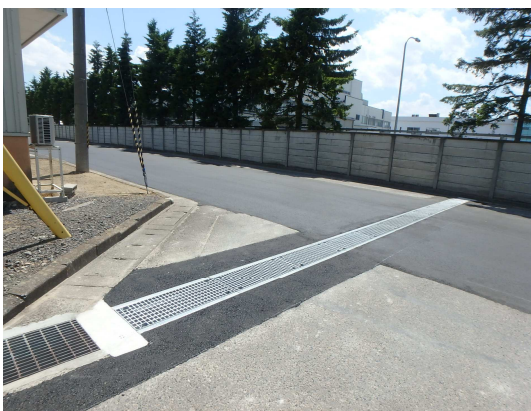
横断側溝設置完了
