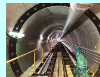
小原田導水管内部
