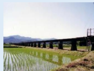
安積疏水 水橋（三穂田町）
