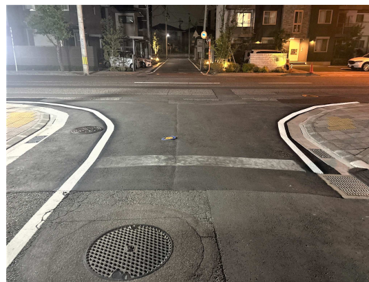
舗装仮復旧完了
