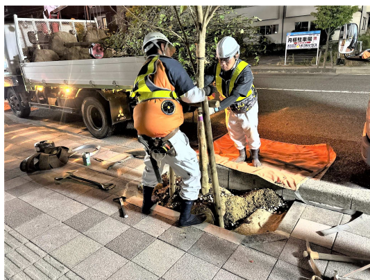
街路樹復旧状況
