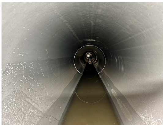
管渠布設完了
