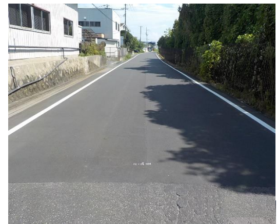
【舗装補修後の市道】
