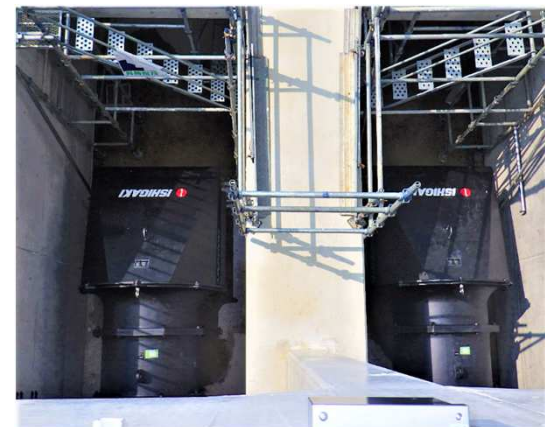
主ポンプ設置完了
