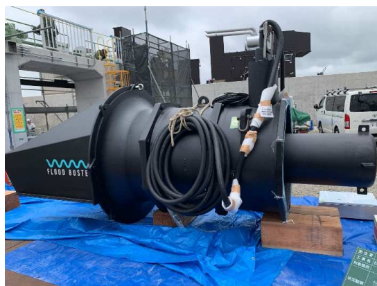
主ポンプ搬入状況
