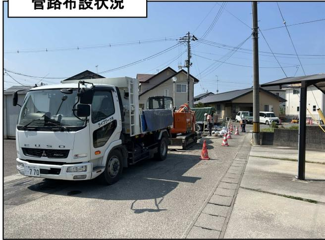
試験掘をおこない水道管などの既設埋設管を確認して、下水道管理設位置が決定しました。
