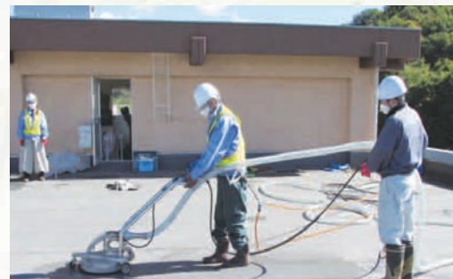
学校校舎の屋上除染
