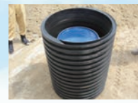
除去土壌を容器に入れ良質土で遮蔽のうえシートで覆う
