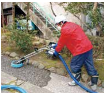
吸引式高圧洗浄作業
