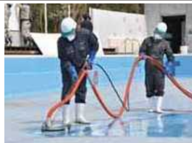
吸引式高圧洗浄機でプールを除染
