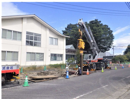
親杭（H鋼）撤去状況
