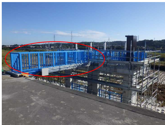
管理橋設置完了
