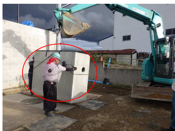
油水分離槽設置状況
