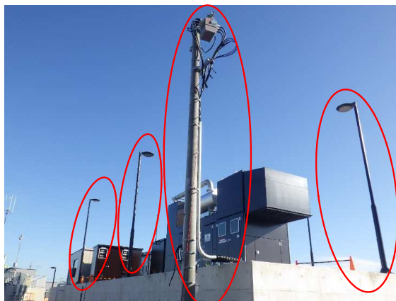
引込柱、照明灯設置完了
