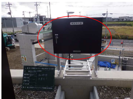
接地端子盤設置完了
