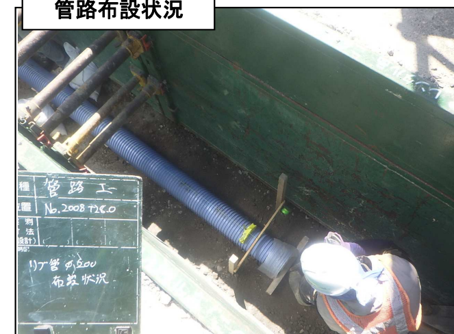
管路布設状況
