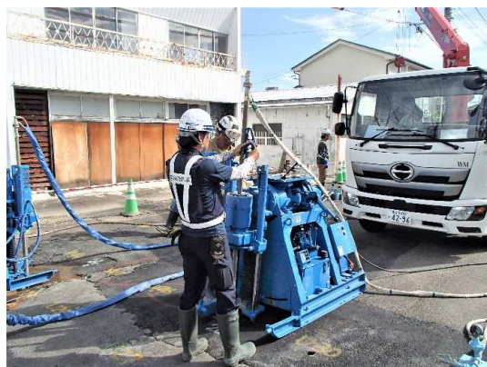
発進立坑 地盤改良工状況
