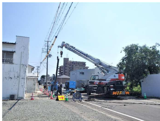
発進立坑 鋼矢板圧入状況
