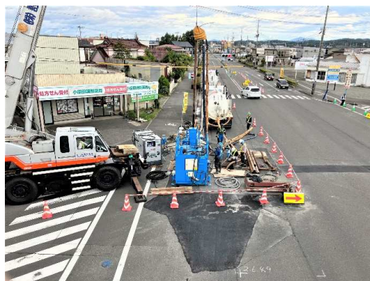
割込立坑 地盤改良工状況
