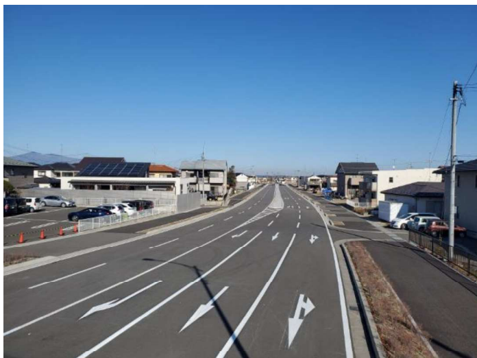
開通した内環状線（芳賀・横塚地区）
