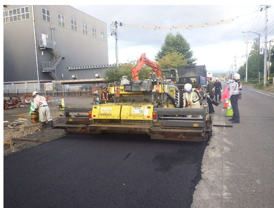
舗装仮復旧状況
