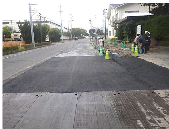
舗装仮復旧完了
