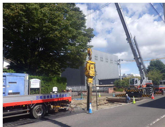
親杭（H鋼）引抜き状況
