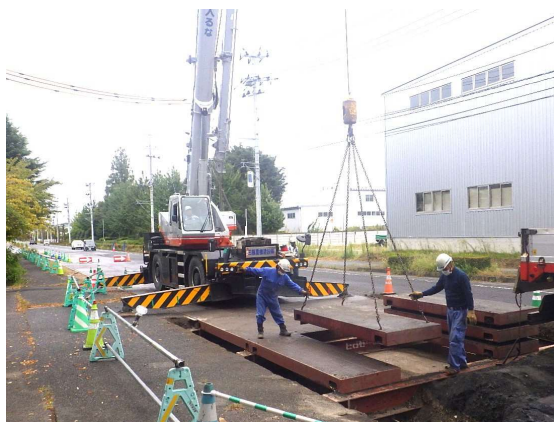
覆工板撤去状況
